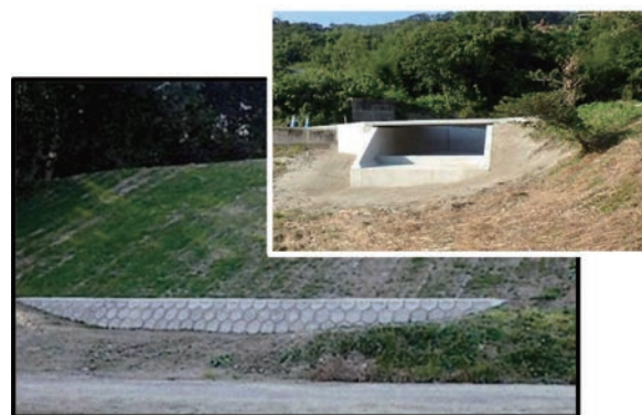
図－４ ため池の堤体復旧と併せ行う 未被災の洪水吐きの拡幅
