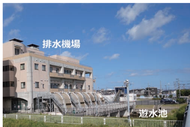
図－1 対象とした排水機場とその遊水池
