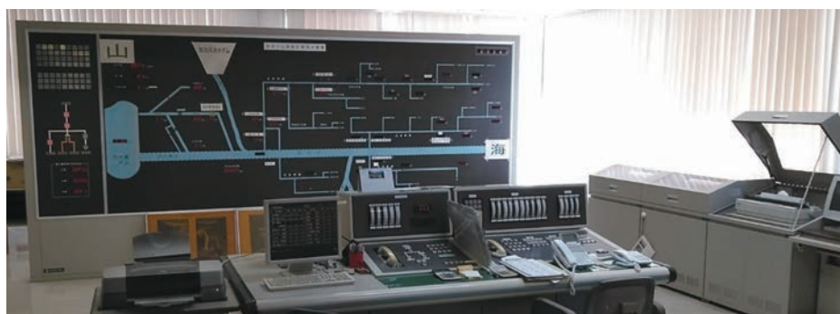
写真－1 既設水管理施設
